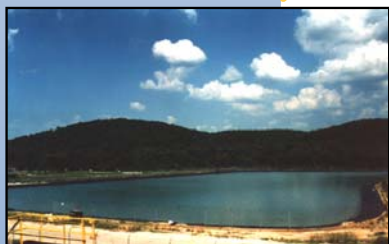
Manejo de aguas residuales
