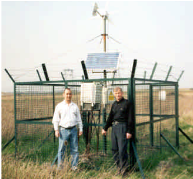
Frank Boyes, BRM (izquierda) y Boris Popov, Baltelectro, inspeccionan la nueva estación de control de calidad del aire perimetral de energía solar y eólica
