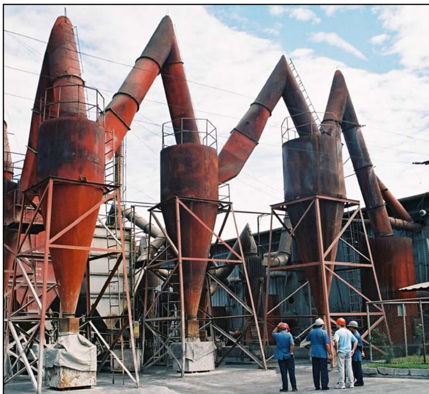
La sección de recolección de polvo en una planta procesadora de plomo.
